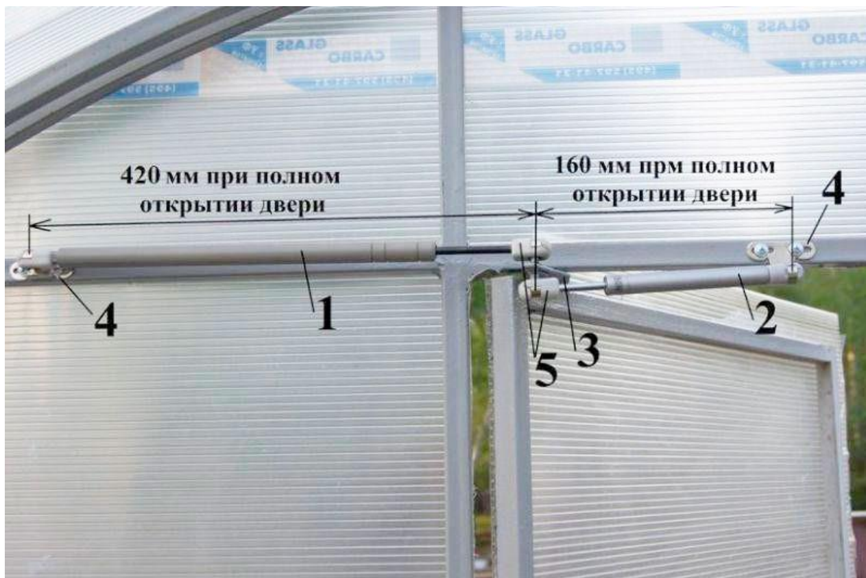
Примеры установки термопривода на дверь или форточку:
