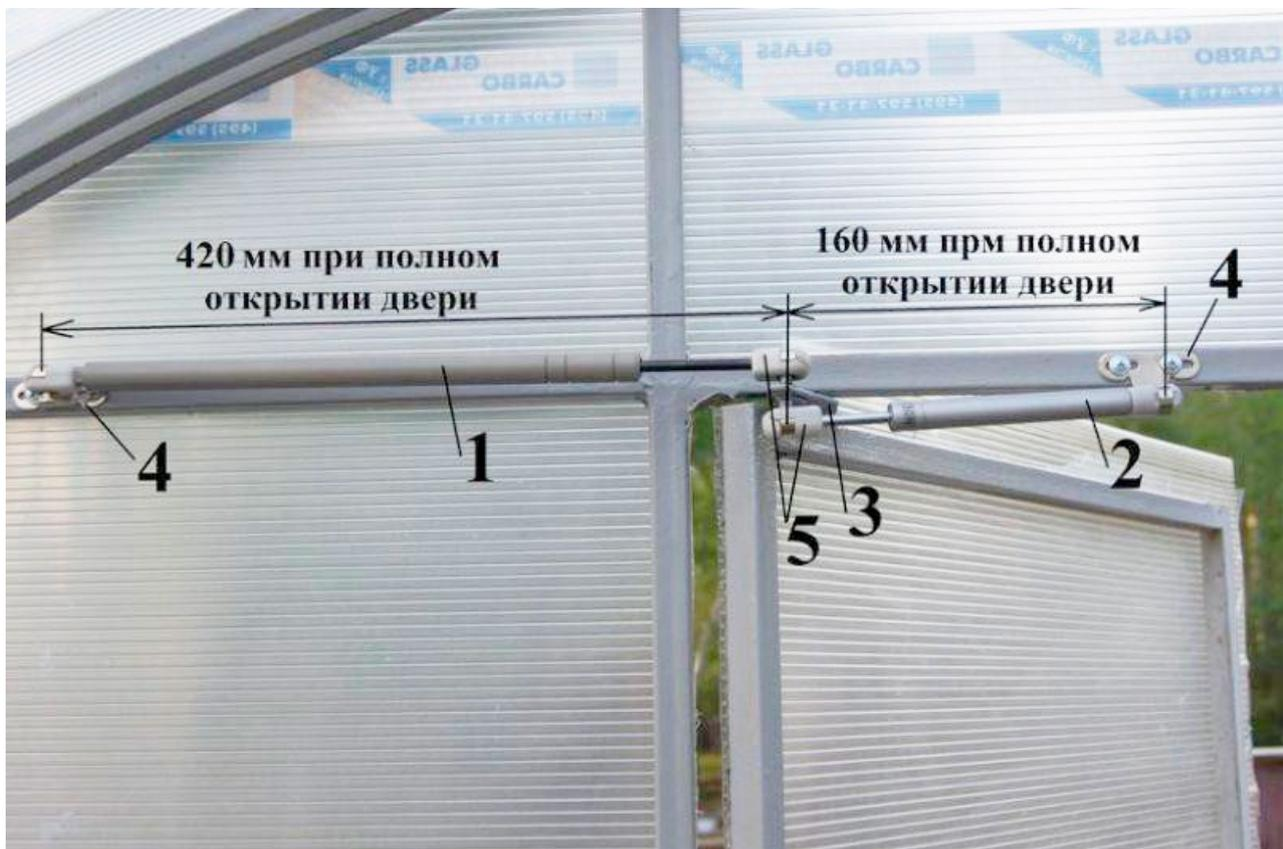
Примеры установки термопривода на дверь или форточку:
