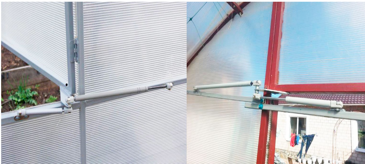
Примеры установки термопривода на дверь или форточку:
